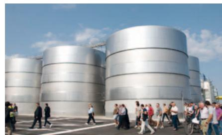
“In perfetta sintonia con la filosofia di Agrintesa – conclude Moretti – la sala di pressatura è stata costruita in Bioedilizia; è stato inoltre realizzato un impianto di depurazione di ultima generazione, con una capacità di 100 metri cubi al giorno e una capacità di stoccaggio in serbatoi inox di 800 metri cubi”.
