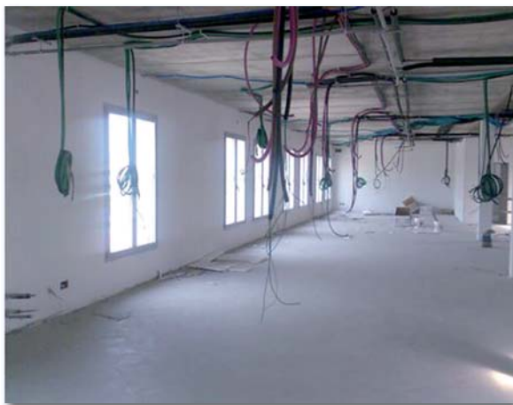
Interno dei locali in fase di ristrutturazione.
