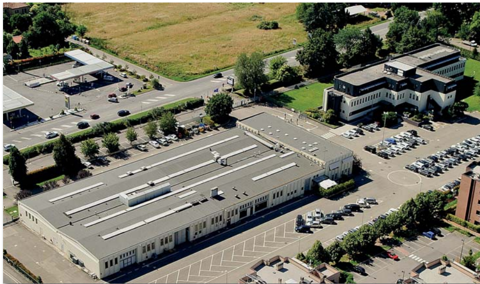
La Sede di Conserve Italia a San Lazzaro di Savena (Bologna).
