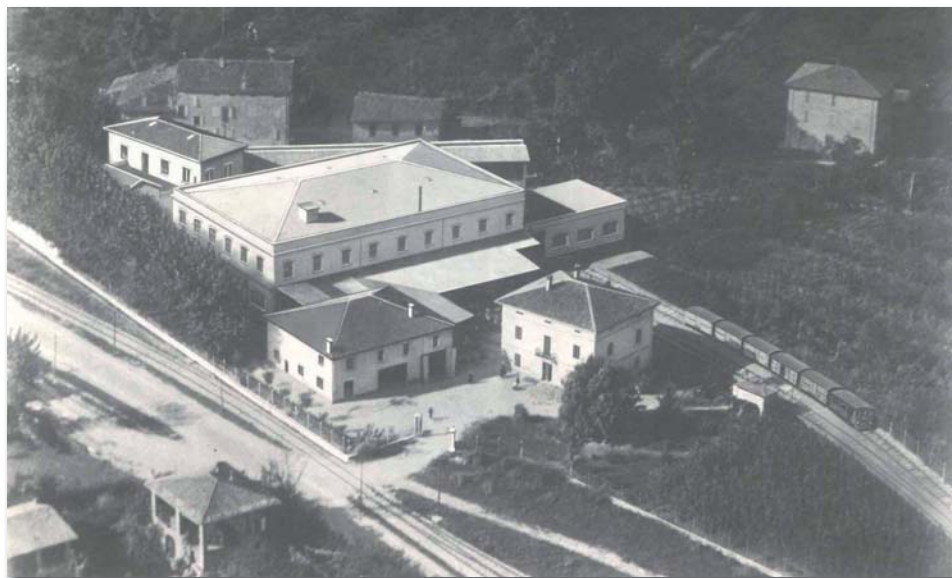
Foto dello stabilimento Coop. Garagnani di Savignano sul Panaro (MO).
