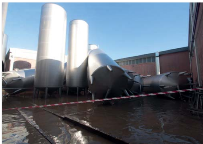
I danni dell'alluvione nel piazzale esterno dello stabilimento di Conserve Italia di Albinia (GR).
