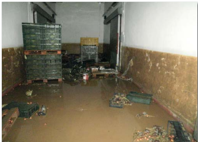
Lo stabilimento Co.Pa.Ca. danneggiato dall'alluvione.
