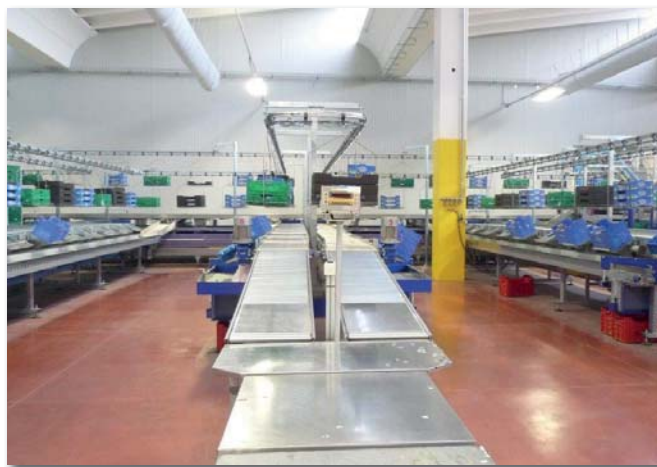
La sala di lavorazione di Ital-frutta dopo la ricostruzione dello stabilimento.
