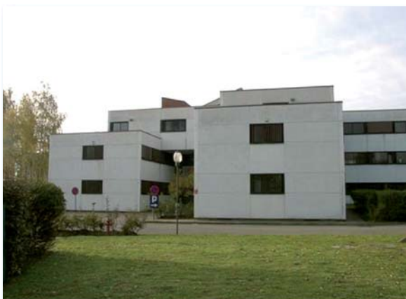
L'edificio di Villanova di Castenaso dopo la ristrutturazione e l'ampliamento.
